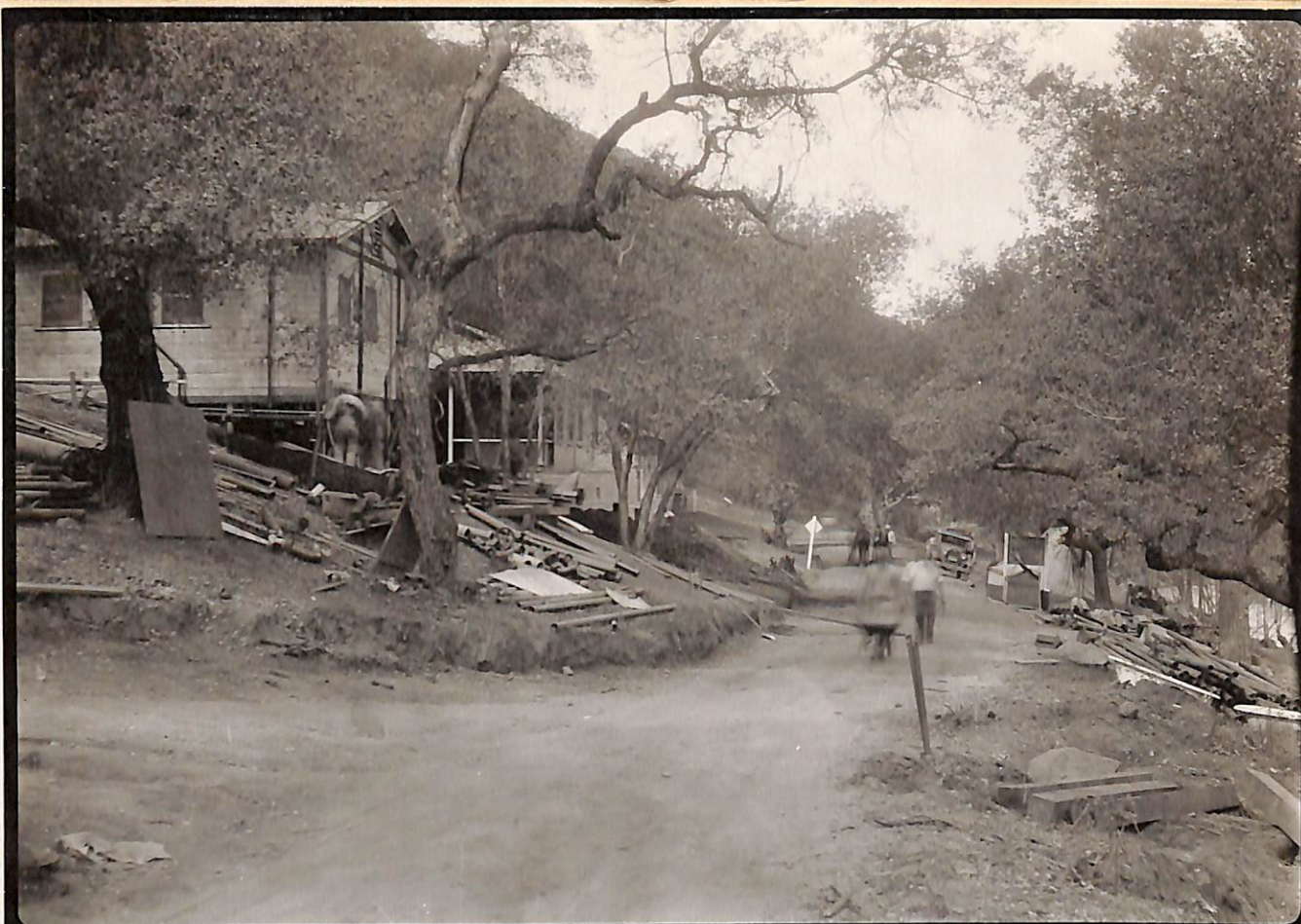
3-14-32. C.S.D. El Capitan Dam. City Camp.
