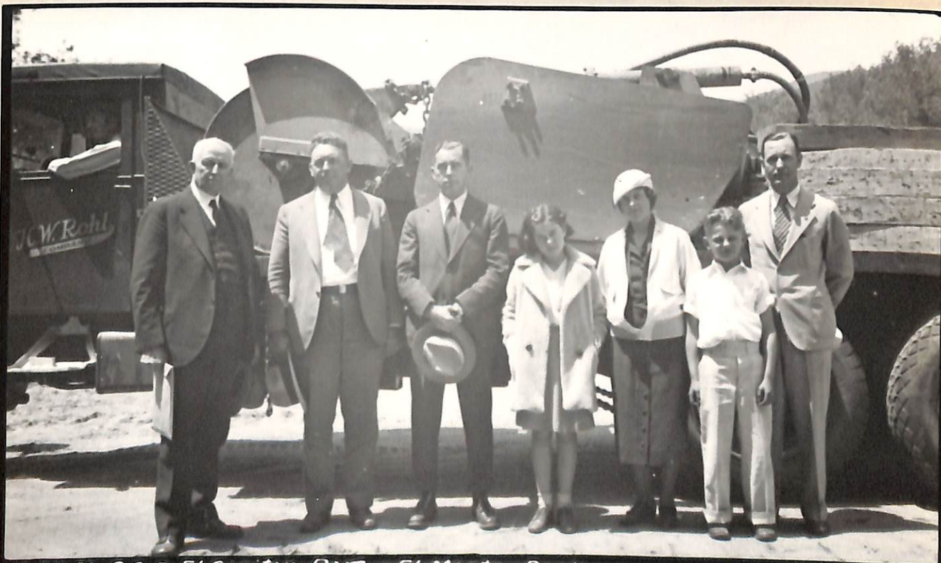
4-24-32. C.S.D. El Capitan Dam. El Monte Park.
