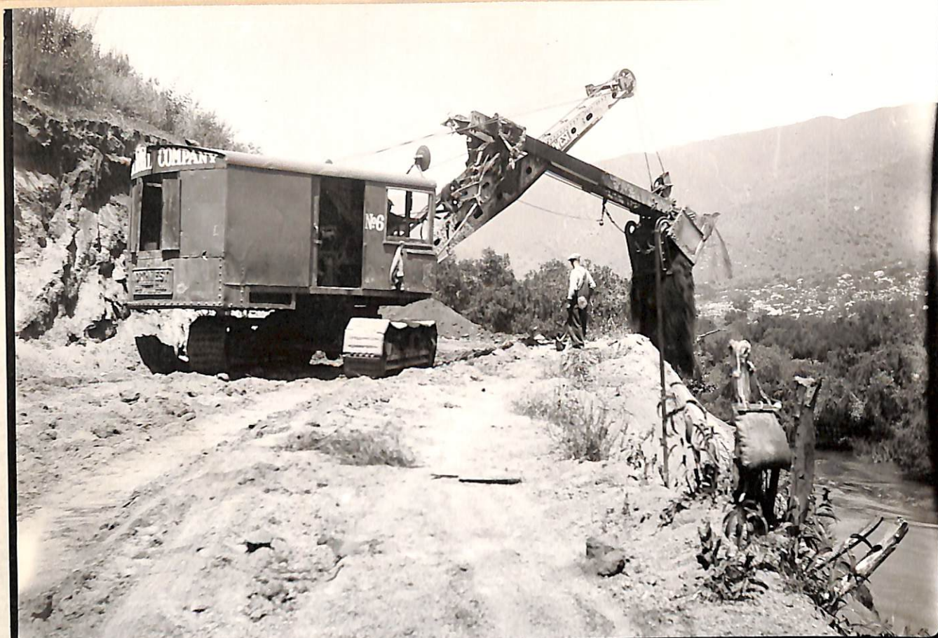
4-30-32. C.S.D. El Capitan Dam. El Capitan - El Monte Park Road, Mile 1.6.
