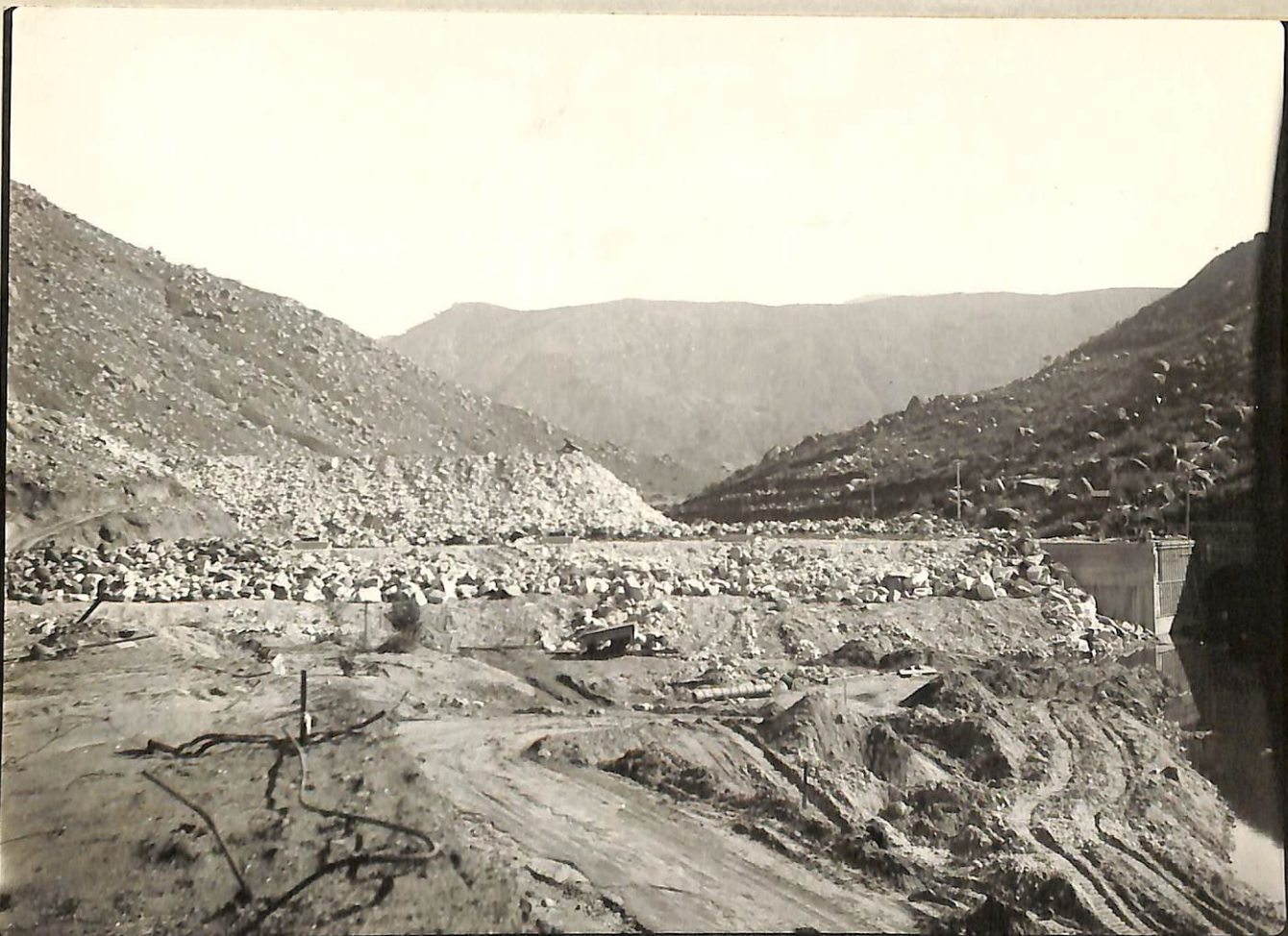
12-27-32. C. S. D. El Capitan Dam. Looking Upstream.
